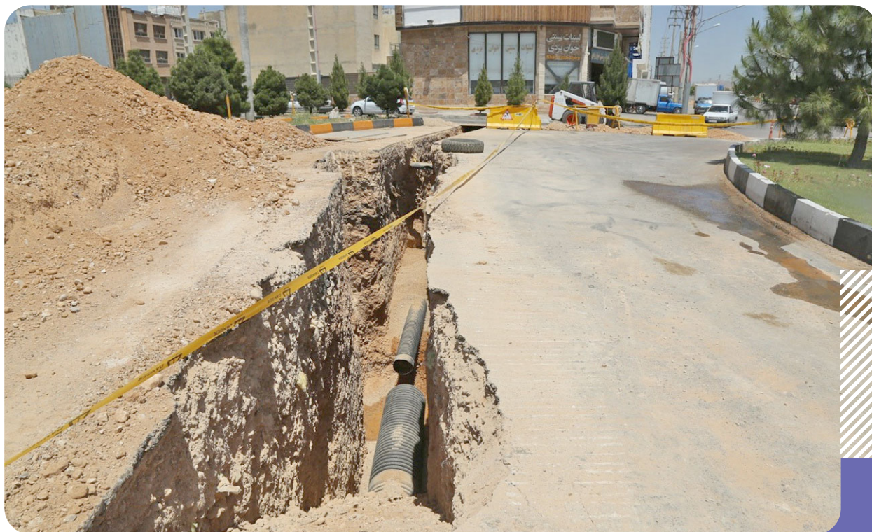
اجرای شبکه فاضلاب به روش فاینانس جاری در منطقه گلستان شمالی شهر شیراز
